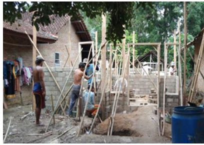
Gambar 1. Pembangunan Bantuan Rumah
