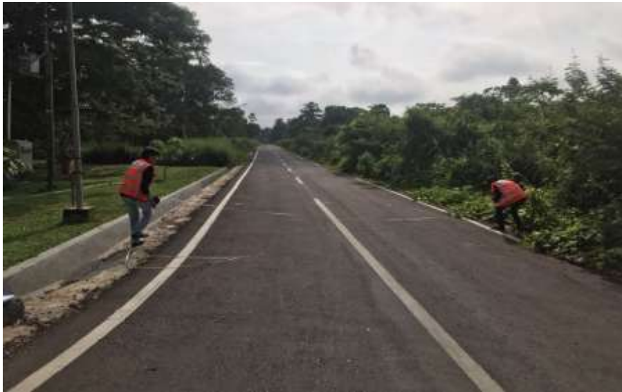
Gambar 3. Kondisi Ruas Jalan Akses DPPU Haluoleo
