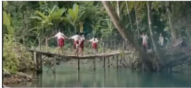
Gambar 1. Anak-Anak Berjalan Melewati Jembatan Kayu Yang Rusak Menuju Sekolah
