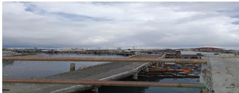
Gambar 14. Akses Pembangunan Jembatan Jika Dilihat Dengan Jarak Dekat
