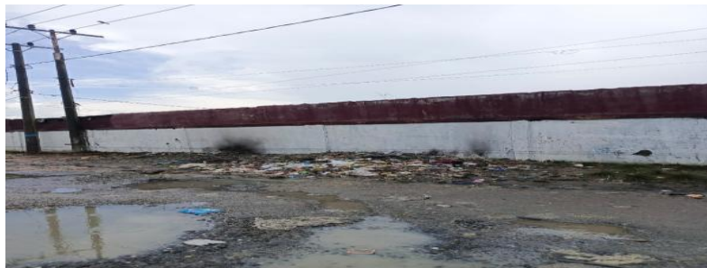
Gambar 11. Kondisi Lingkungan Banyak Sampah di Jalan Umum Sekitar Rumah Warga
