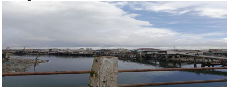
Gambar 13. Akses Pembangunan Jembatan
