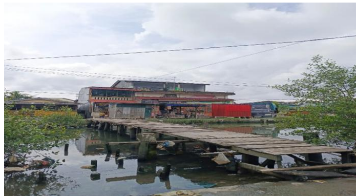
Gambar 6. Jembatan Penghubung Antar Rumah Warga dan Sekolah
