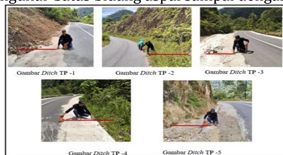
Gambar 8. Kondisi Lebar parit (ditch) di Jalan Pakkat Km 170-175 Kabupaten Humbang Hasundutan (TP -1, TP -2, TP -3, TP -4, TP -5)
