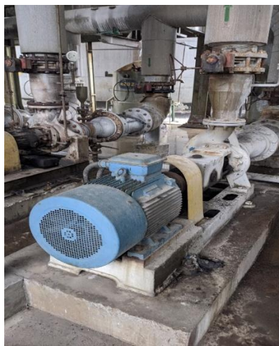
Gambar 1. Pompa Sentrifugal
