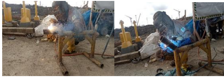
Gambar 9. Posisi Pengelasan yang di pakai dalam penelitian a) 5G, b) 6G
