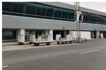
Gambar 3. GSE yang Terparkir Tidak Pada Tempatnya Sumber: Penulis (Oktober 2025–Februari 2026)
